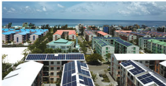
◆ 马尔代夫 1.5 兆瓦光伏电站项目
