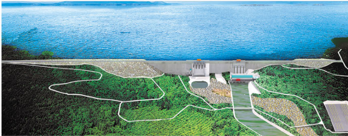
◆ 尼日利亚宗格鲁 700 兆瓦水电站项目
